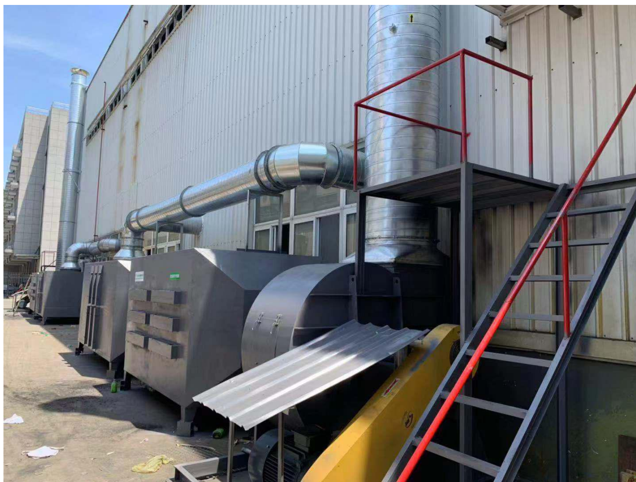
图 4-1 喷漆废气整改后的装置排气筒现状图
