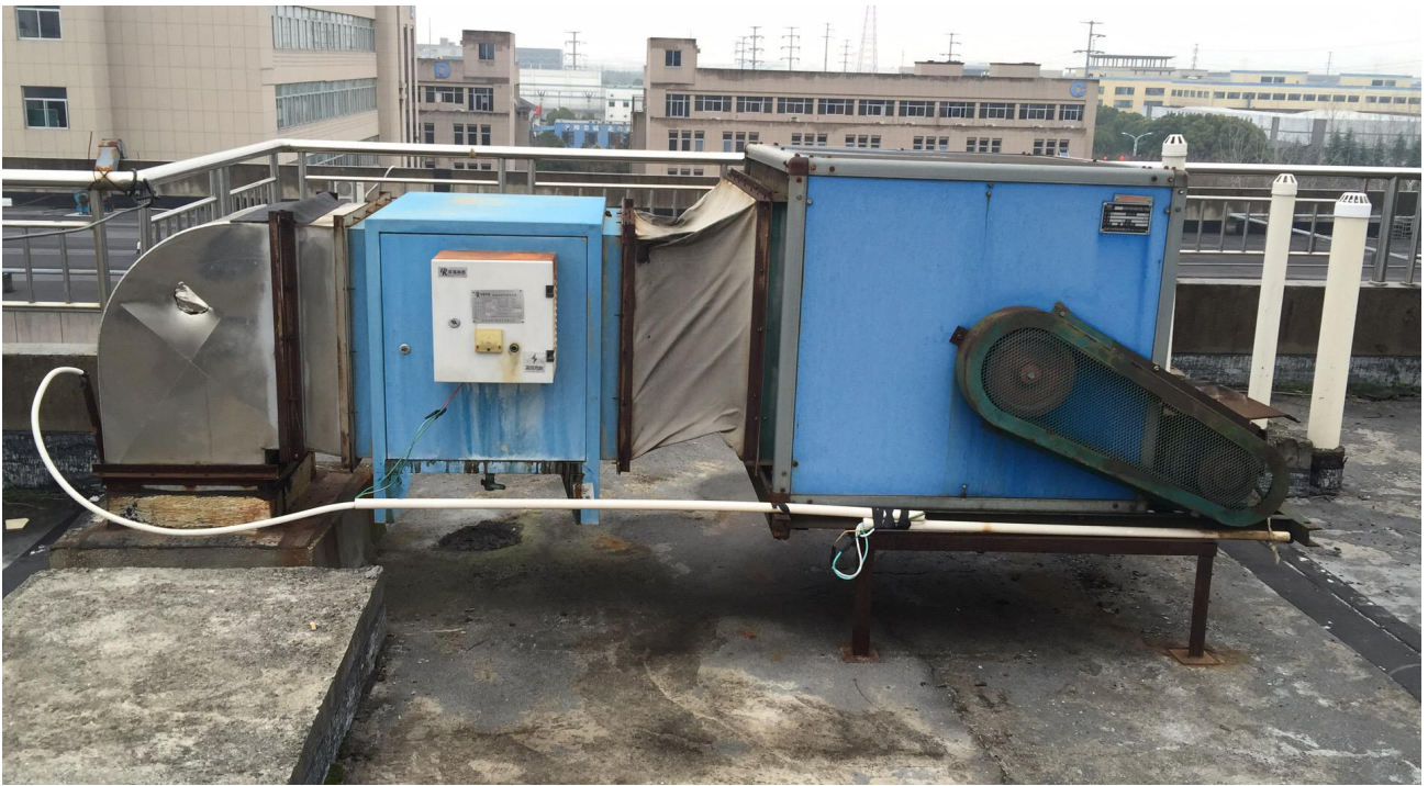
图 4-2 油烟净化器装置现状图
